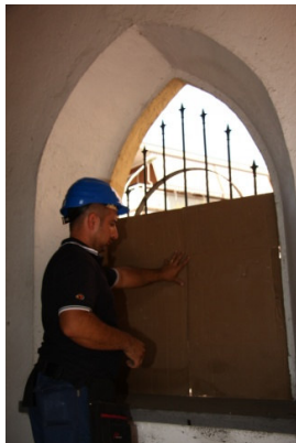
Tamponatura delle finestre
