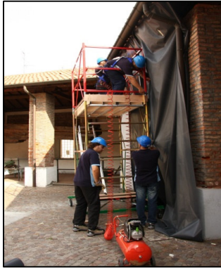
Allestimento della Camera Aerotermica
