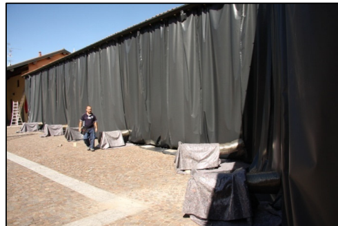
Allestimento dei convogliatori di calore
